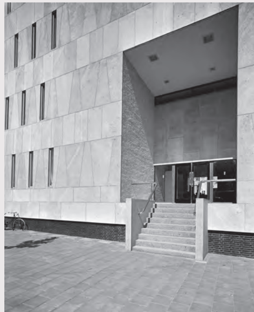
Entree aan het Lange Voorhout (links) en aan het Korte Voorhout (rechts).
