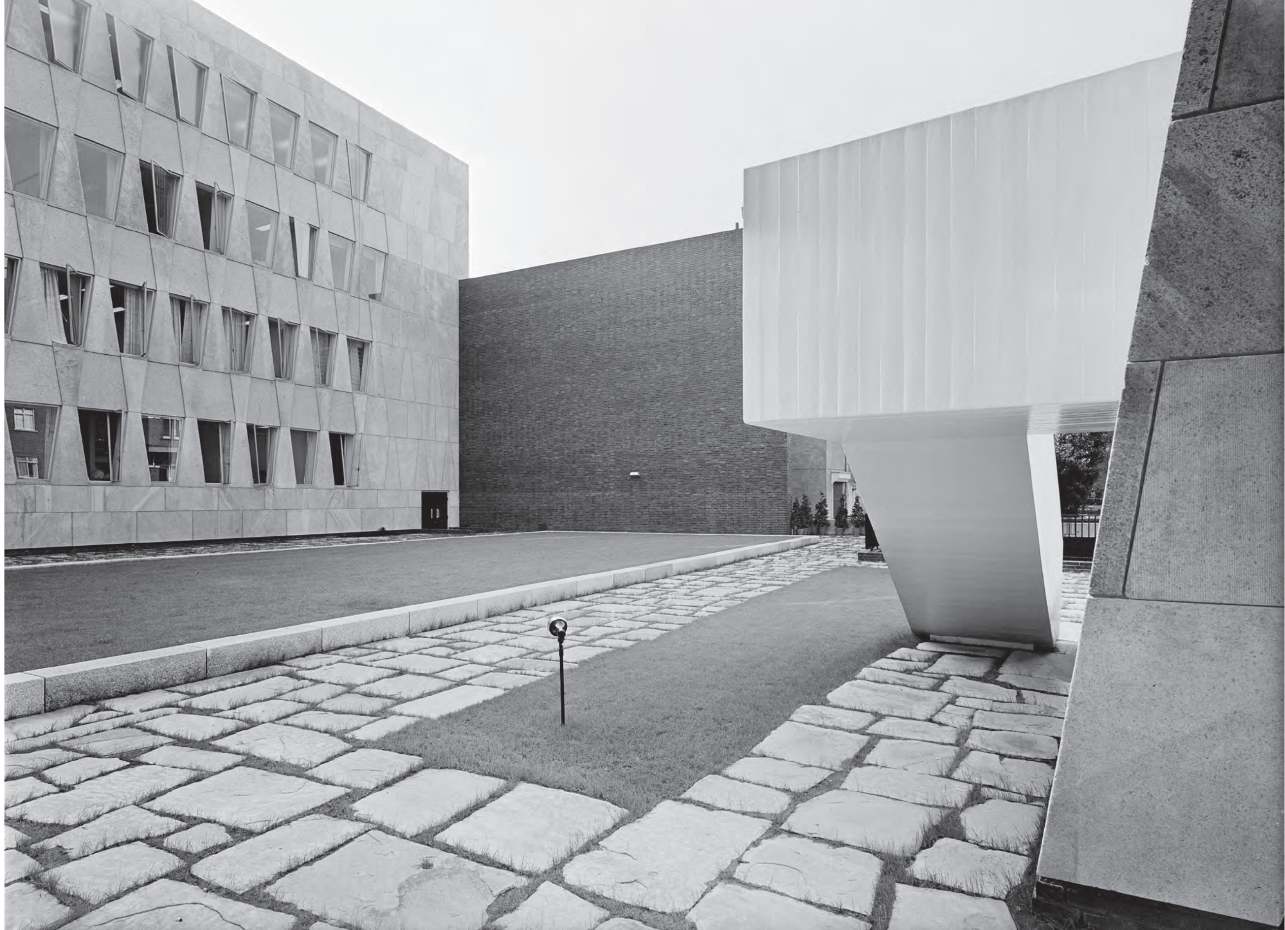
Binnenrein met verhoogd grasvlak, plaveisel van breuksteen en noodtrap van het auditorium.
