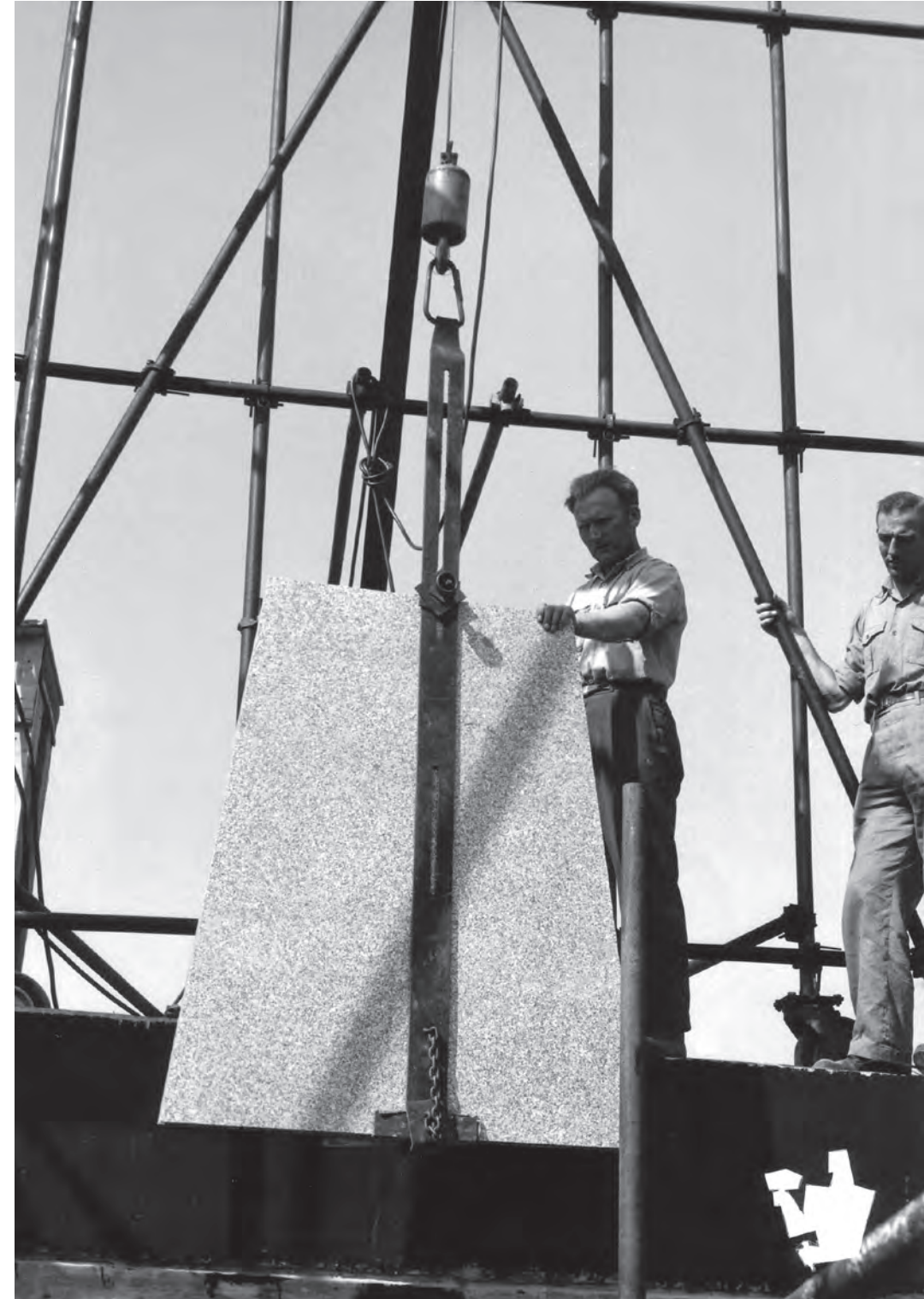
Plaatsing van de natuurstenen panelen, rechts- onder op de foto het logo van natuursteenbedrijf Van Stokkum uit Venlo.
