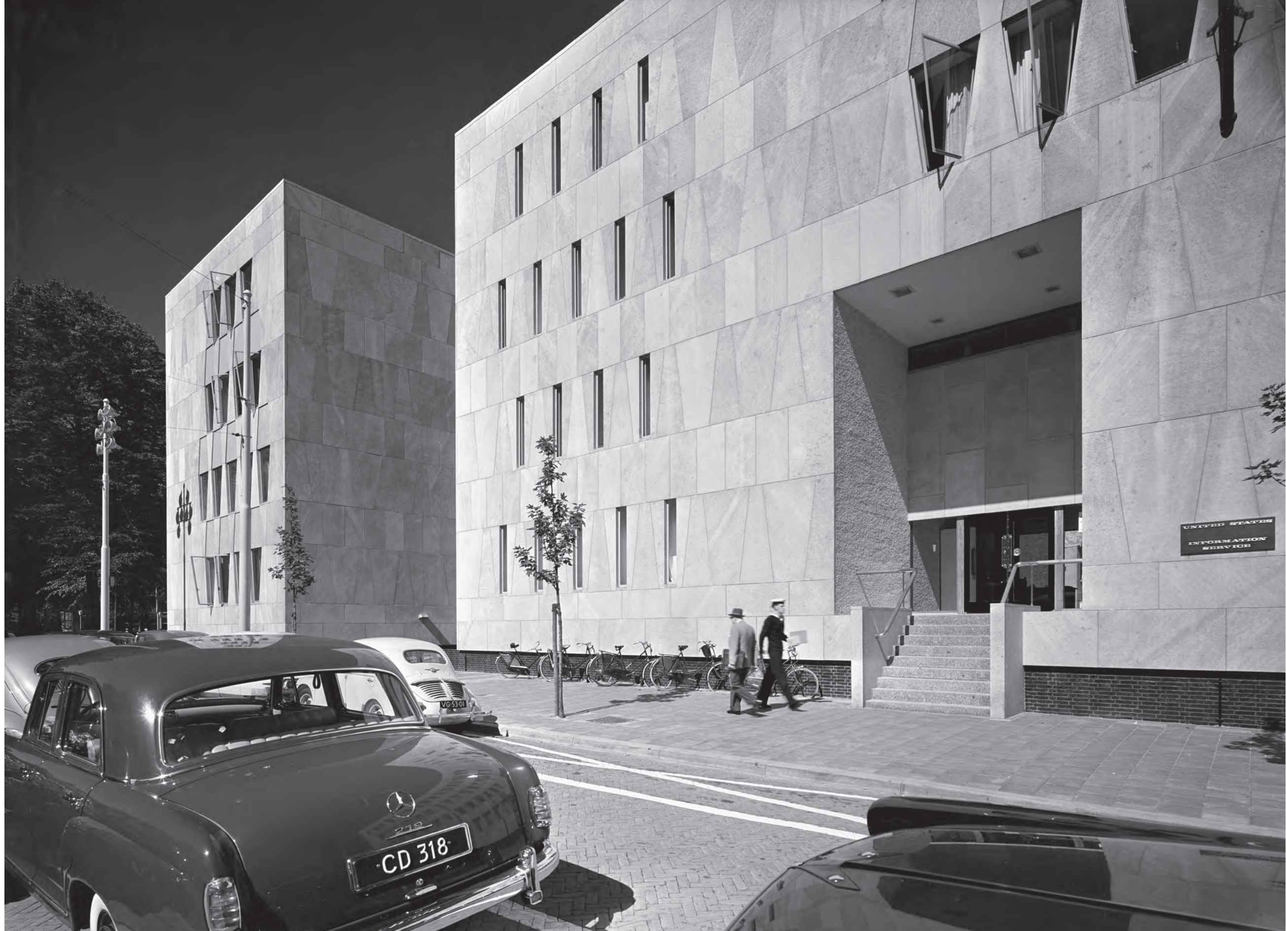
Gevel aan het Korte Voorhout met de entree voor USIS en het achterliggende auditorium.
