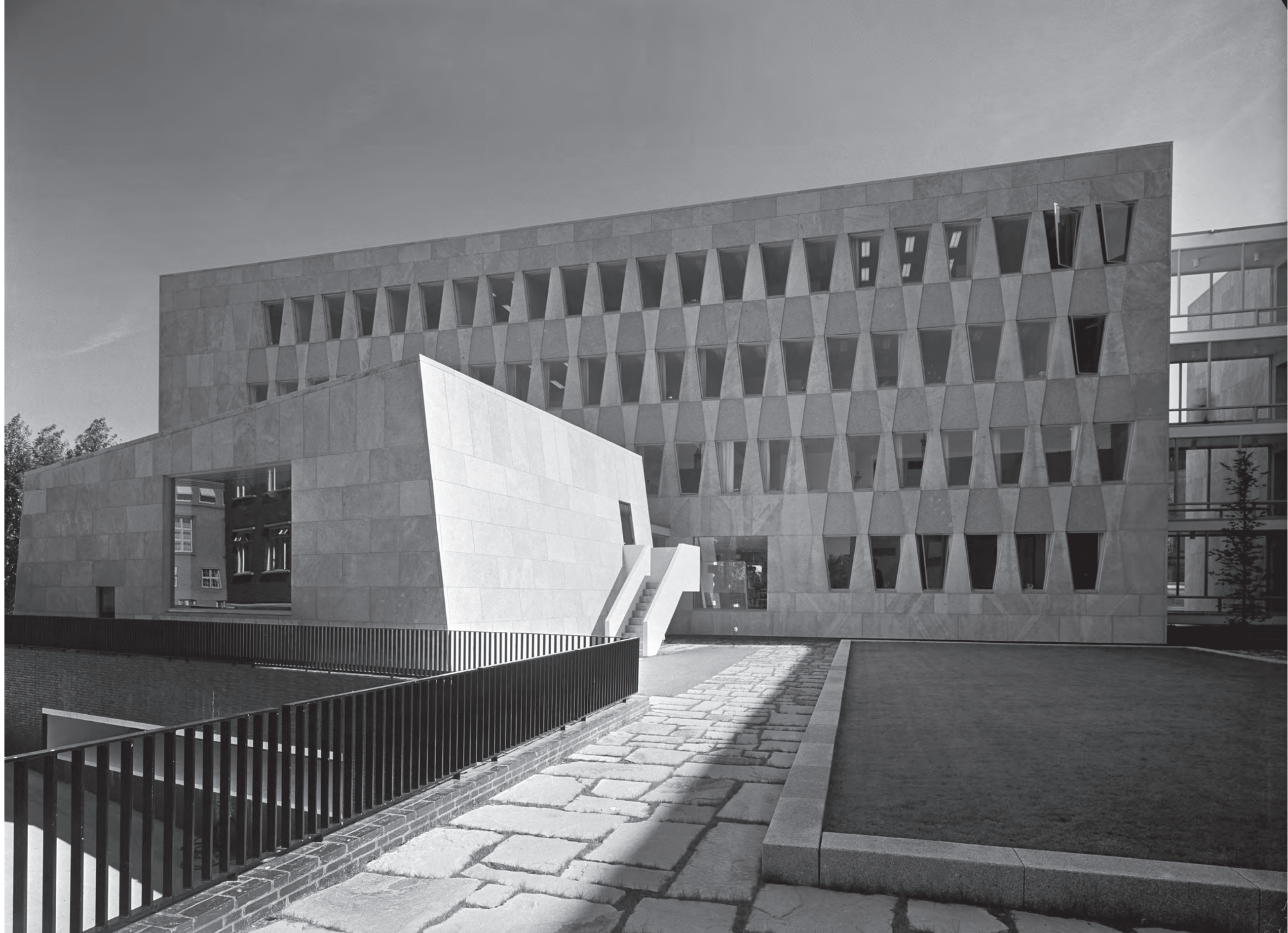
Binnerrein met audito- rium, toegang parkeerkelder en verhoogd grasvlak.
