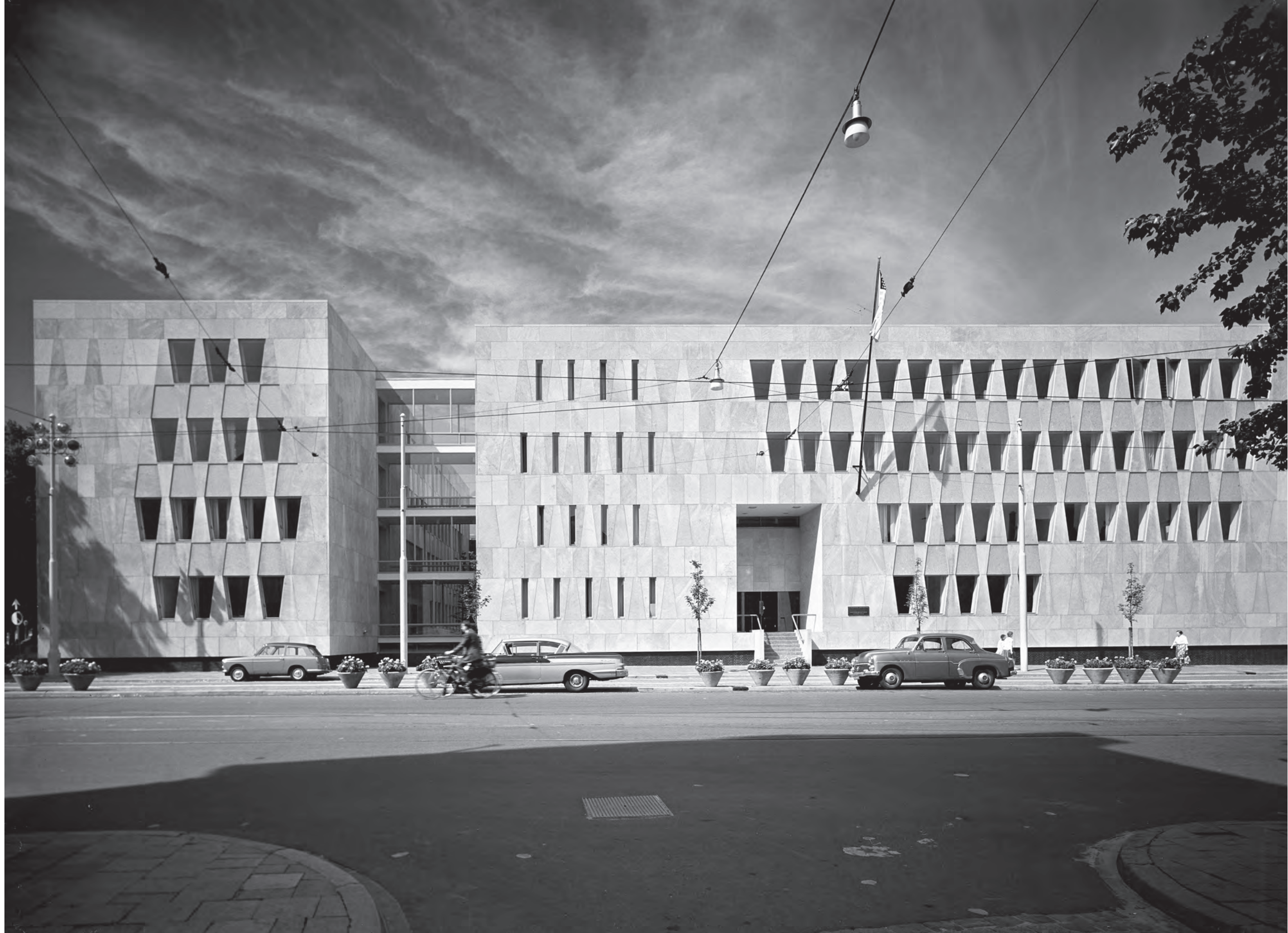
Gevel aan het Korte Voorhout vlak na oplevering.
